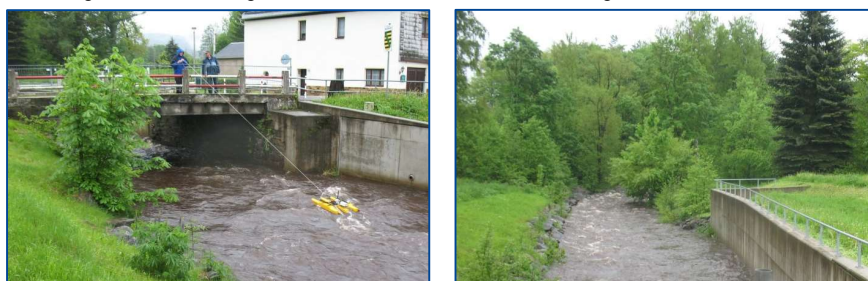
ADCP-Messung 31.05.13, Fußgängerbrücke Natzschung Stat. 0+205 (li: uh; re:oh.)
